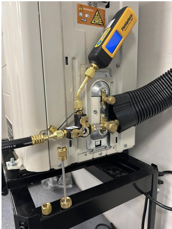
Deretter kan du koble på manometer og vakuumere slangene for trykkmålinger.
